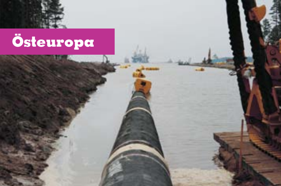
FOTO: NORD STREAM AG
